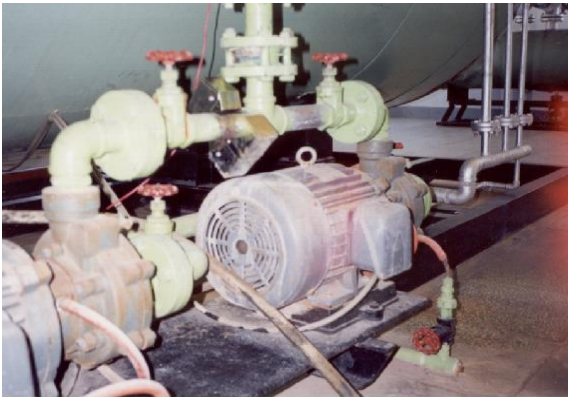
圖 10 A 廠鍋爐蒸汽用水進水管上安裝流體磁化器
